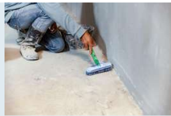
Yüzeyde kırık, bozuk bölgeler onarılması
