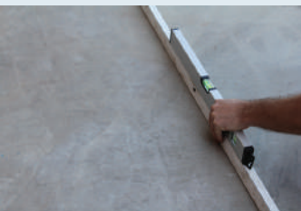
Yüzeyin düzgünlüğünün kontrol edilmesi
