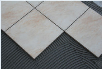
Seramiğin yerleştirilmesi
