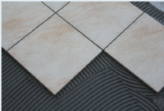
Seramiğin yerleştirilmesi
