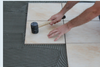
Çekiçle vurulup seviyelendirilmesi
