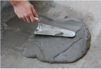
Harçın mala yardımı ile yüzeye aktarılması
