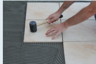
Çekiçle vurulup seviyelendirilmesi
