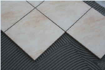
Seramiğin yerleştirilmesi
