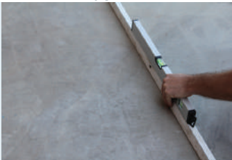
Yüzeyin düzgünlüğünün kontrol edilmesi
