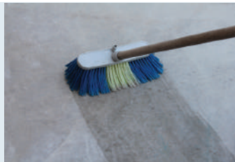
Yüzeyin temizlenip nemlendirilmesi
