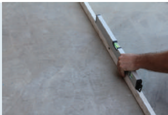
Yüzeyin düzgünlüğünün kontrol edilmesi
