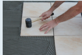
Çekiçle vurulup seviyelendirilmesi
