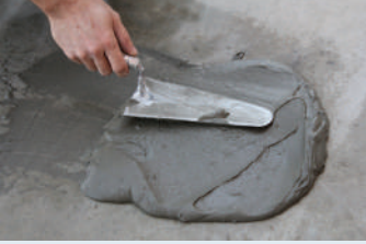
Harçın mala yardımı ile yüzeye aktarılması
