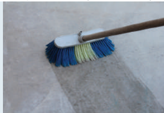
Yüzeyin temizlenip nemlendirilmesi
