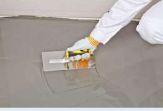
Harcın kalınlığı ayarlanmalı
