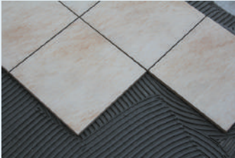
Seramiğin yerleştirilmesi
