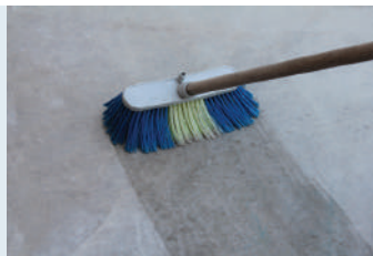
Yüzeyin temizlenip nemlendirilmesi
