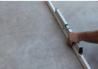
Yüzeyin düzgünlüğünün kontrol edilmesi
