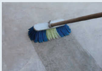
Yüzeyin temizlenip nemlendirilmesi
