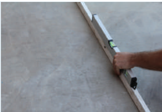
Yüzeyin düzgünlüğünün kontrol edilmesi
