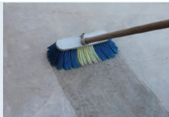
Yüzeyin temizlenip nemlendirilmesi
