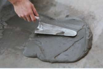
Harçın mala yardımı ile yüzeye aktarılması
