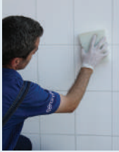
Nemli sünger ile derz yüzeyinin düzeltilmesi
