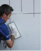
Dolgu malzemesinin duvara uygulanması
