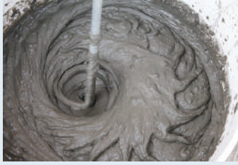
Karıştırıcı ile karıştırma
