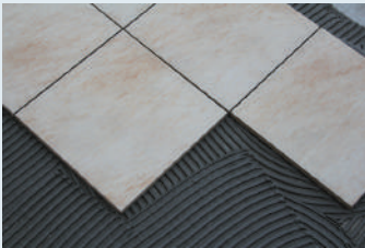
Seramiğin yerleştirilmesi
