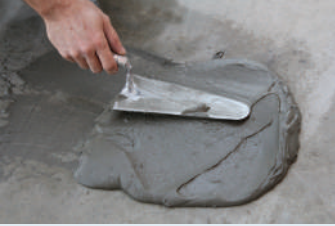
Harç mala yardımı ile yüzeye aktarılması
