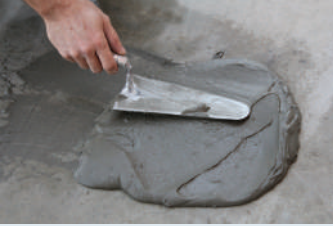
Harçın mala yardımı ile yüzeye aktarılması
